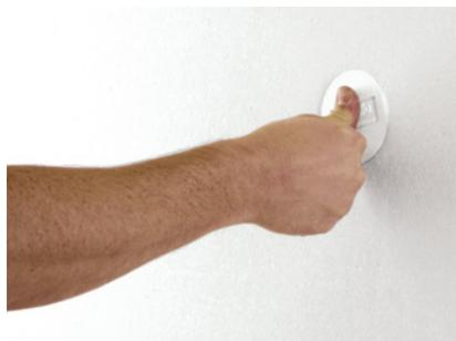
Montagezylinder ZyRillo®-EPS dämmplattbündig in die Ausfräzung pressen.
